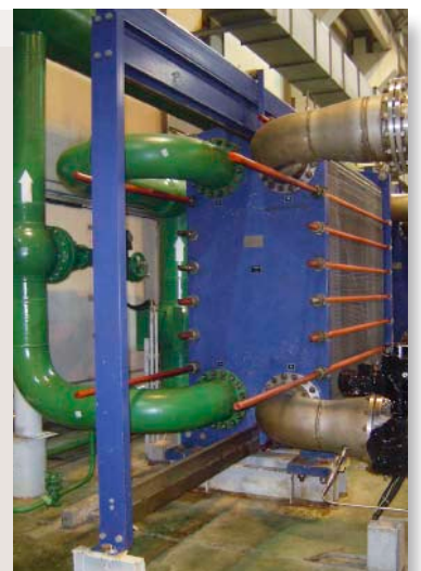
田湾NPPでは、合計46台のアルファ・ラバルのプレート式熱交換器を使用しています
