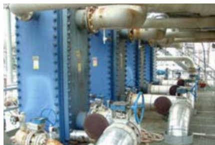
Compabloc, el intercambiador de calor de placas de Alfa Laval, en la refinería en Sarnia.
