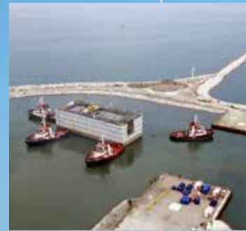
Installation de la dernière partie du barrage anti-inondation.
