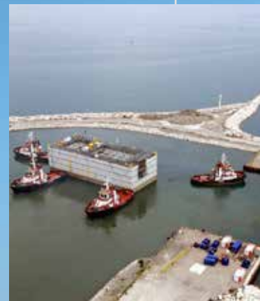
Der letzte Abschnitt des Flutschutzwehrs wird an seinen Platz geschleppt.
