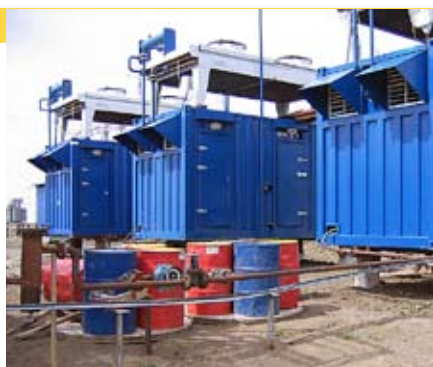
ADD公司在建造其移动式发电设备时，依赖阿法拉伐的干式冷却器。
