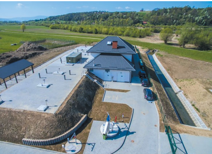
Полностью закрытые ОСК на основе МБР на мембранах MFM Hollow Sheet в г. Новы Сонч, Польша
