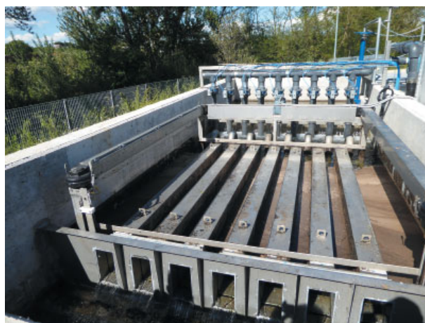
Рис. 19. Изо-Диск. Вид вдоль фильтрующих элементов
