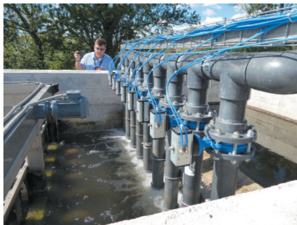
Рис. 20. Клапаны на системе промывки фильтрующих элементов
