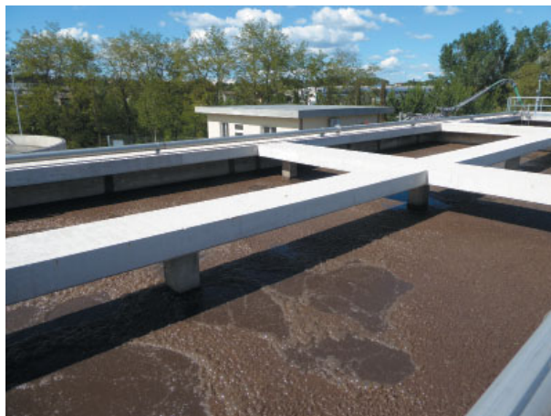
Рис. 13. Зона аэрации аэротенка на ОС «Марчиано»
