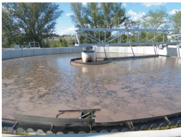
Рис. 14. Пена на поверхности вторичного отстойника
