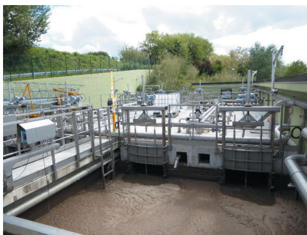
Рис. 5. Сооружения биологической очистки. На переднем плане – биореактор, за ним – мембранное отделение
