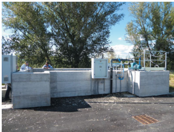
Рис. 15. Общий вид сооружения доочистки Изо-Диск
