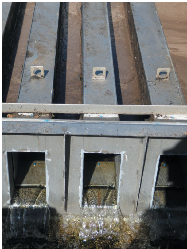
Рис. 18. Излив чистой воды из внутреннего пространства секций Изо-Диска
