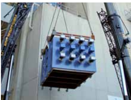
Монтаж котла-утилизатора на заводе финской цементной компании Finnsementti Oy
