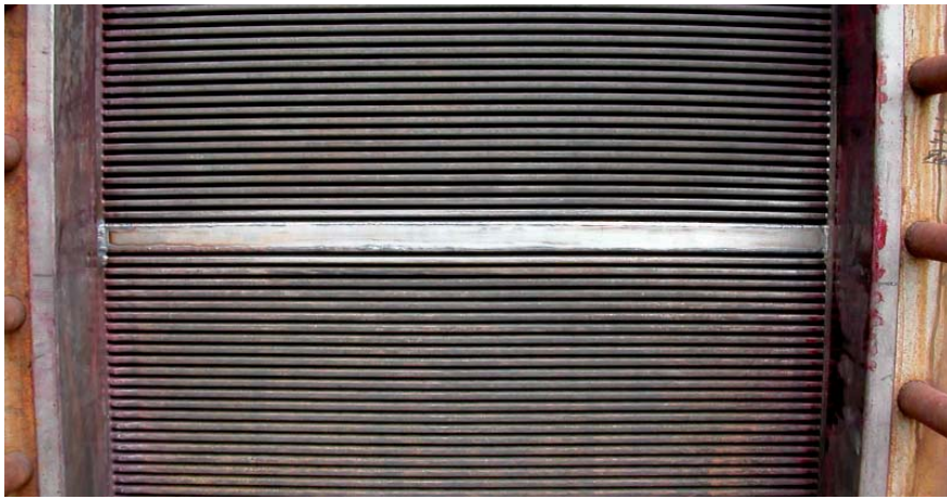
Фотография теплообменника Combraloc с поврежденным каналом, изолированным металлической полосой.
