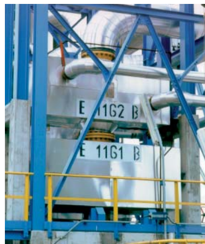
Два из четырех теплообменников Comtrabloc, работающих на одном из европейских НПЗ с 1997 года.
