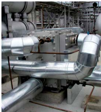
Comrabloc, используемый для предварительного подогрева сырой нефти (2002 год).
