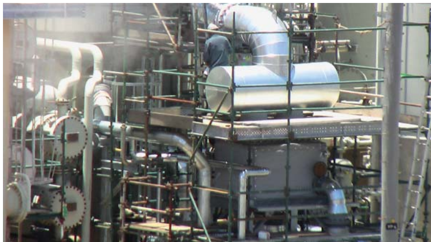
Теплообменник Comtrabloc, функционирующий с 2002 года на одном из австралийских заводов в качестве ребойлера нефти.
