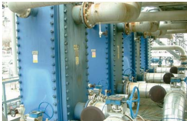
Четыре из восьми конденсаторов Comrabloc
