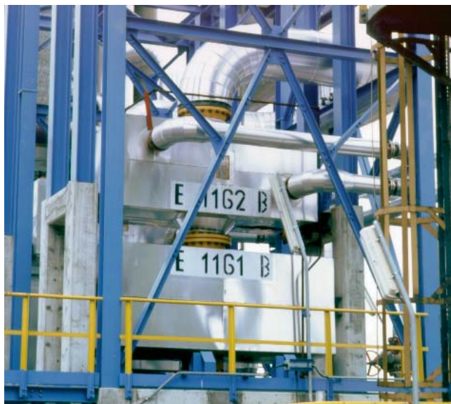
Два из четырех модулей Comrabloc горизонтального монтажа, выполненных из титана и использующихся для конденсации паров в колонне атмосферной дистилляции.
