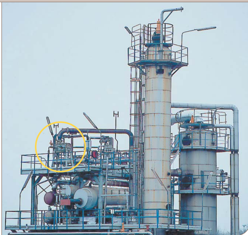
Атмосферная и вакуумная дистилляционные колонны с вакуумным конденсатором Comrabloc (отмечен кружком). Увеличенное изображение — на обратной стороне.
