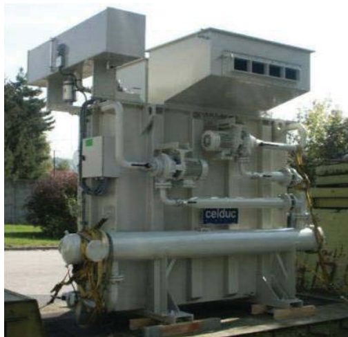
Пример инсталляции кожухотрубного и пластинчатого маслоохладителей на трансформаторе
