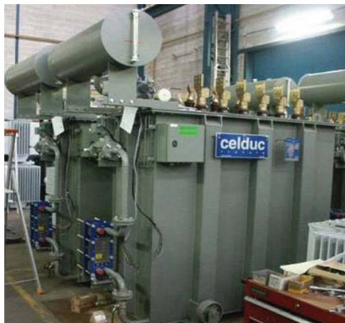
Пример инсталляции кожухотрубного и пластинчатого маслоохладителей на трансформаторе
