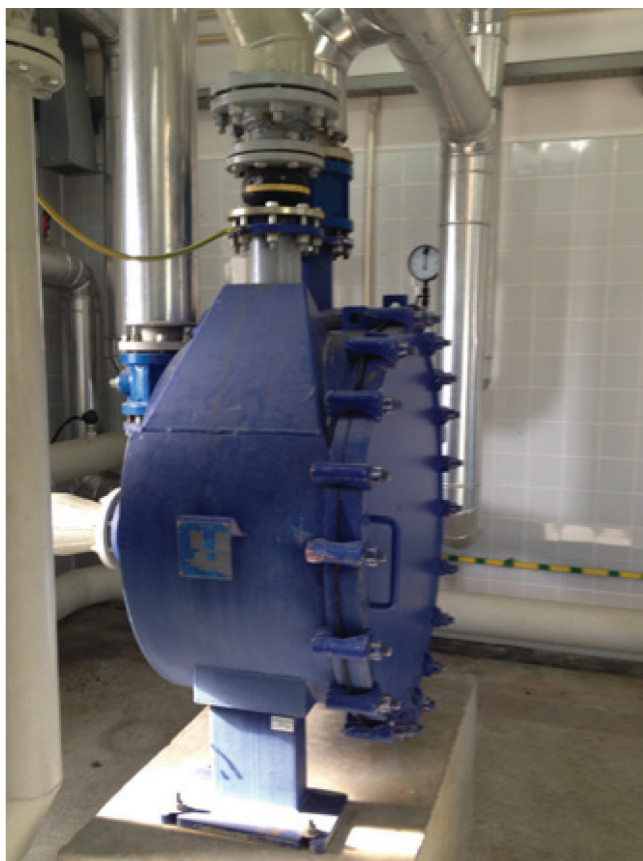
Spółka „Prosna” wykorzystuje dwa spiralne wymienniki ciepła Alfa Laval do ogrzewania komór fermentacyjnych.
