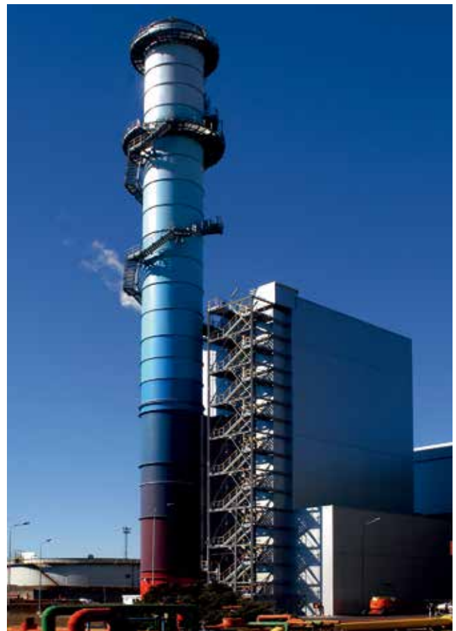
热回收蒸汽发电机与烟囱
