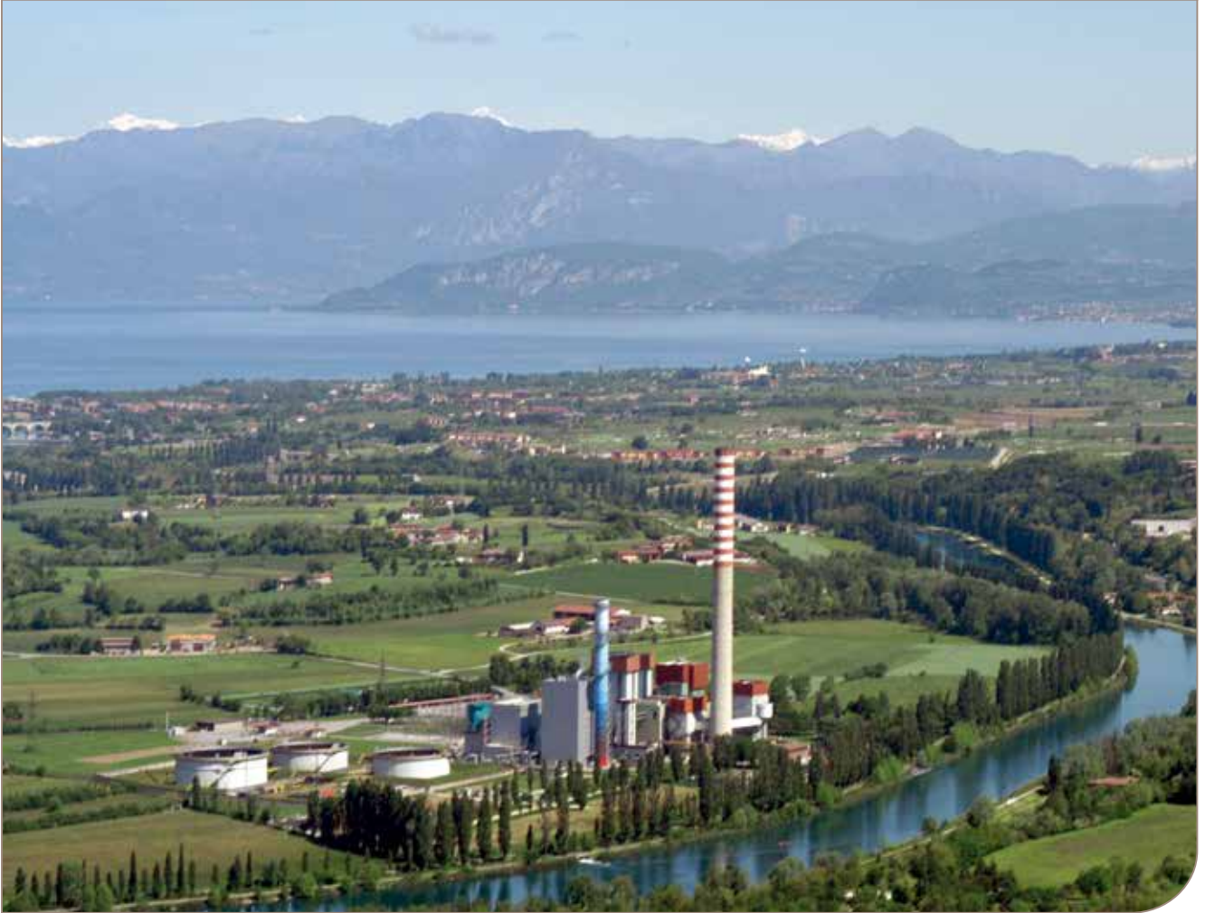
明乔热电厂（俯视图）
