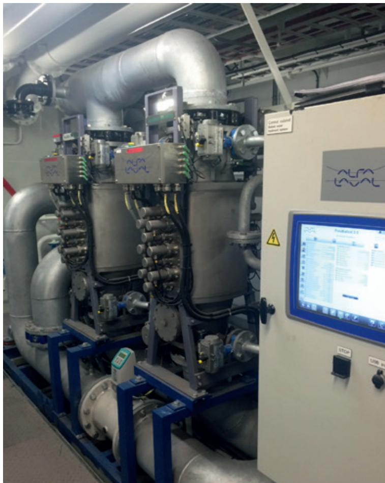
Alfa Laval PureBallast 3.0 - 500 m 3 /h.
